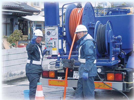
復興への道 —東日本大震災からの復旧記録— 平成 24 年 3 月 25 日
