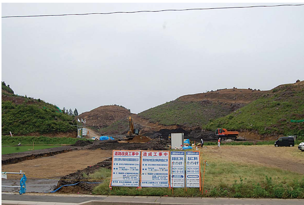
野田村城内地区 高台移転造成工事
