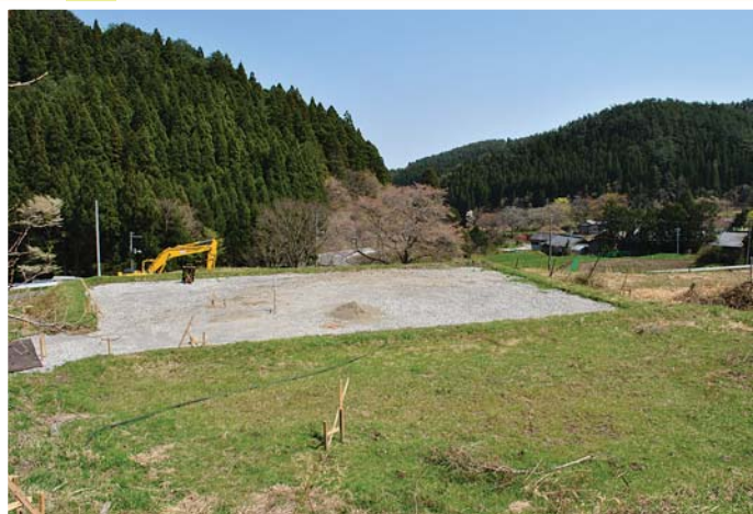
泊地区防災集団移転住宅団地整備（H25）
