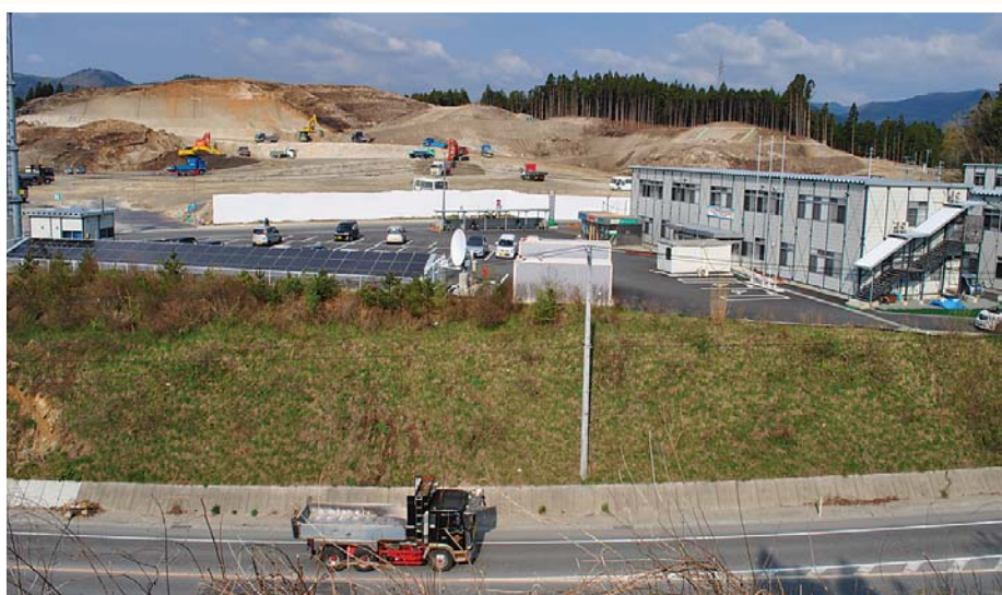
復興拠点整備事業 高田西地区復興整備工事（H25）
