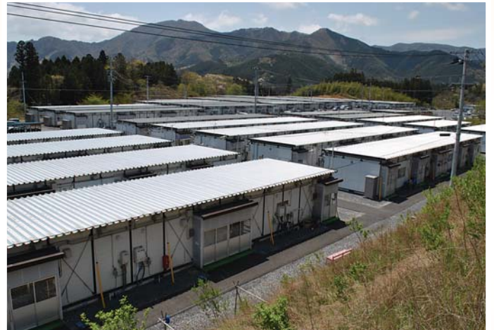
大船渡市 長洞地区応急仮設住宅 (総合公園跡地) (H25)
