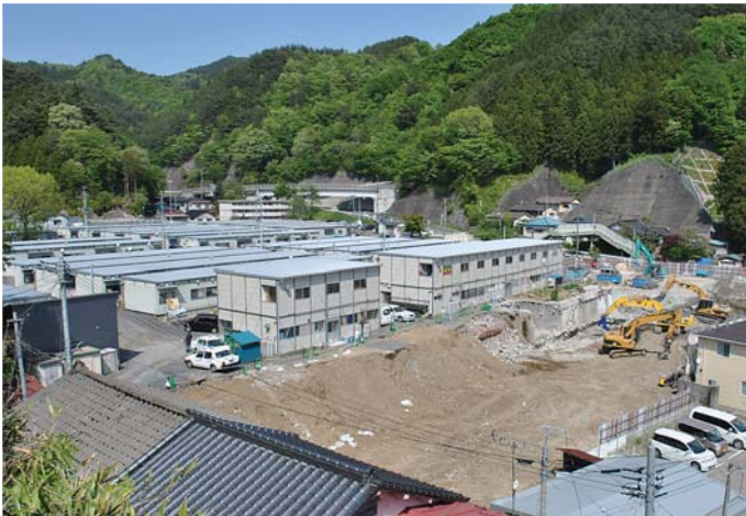
釜石市 天神町仮設住宅跡地に災害公 営住宅が建設される (H25)
