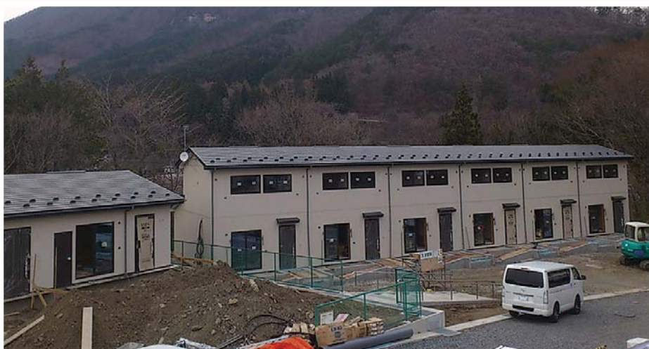
岩泉町 森の越災害公営住宅 (町営15戸) (H25)
