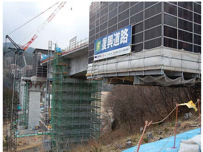
大船渡市 吉浜道路高架橋
