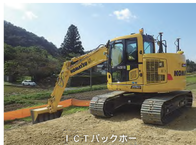
ICTバックホー
