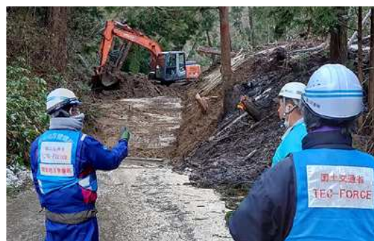
図3:建設業者と連携した道路の緊急復旧(石川県輪島市)
