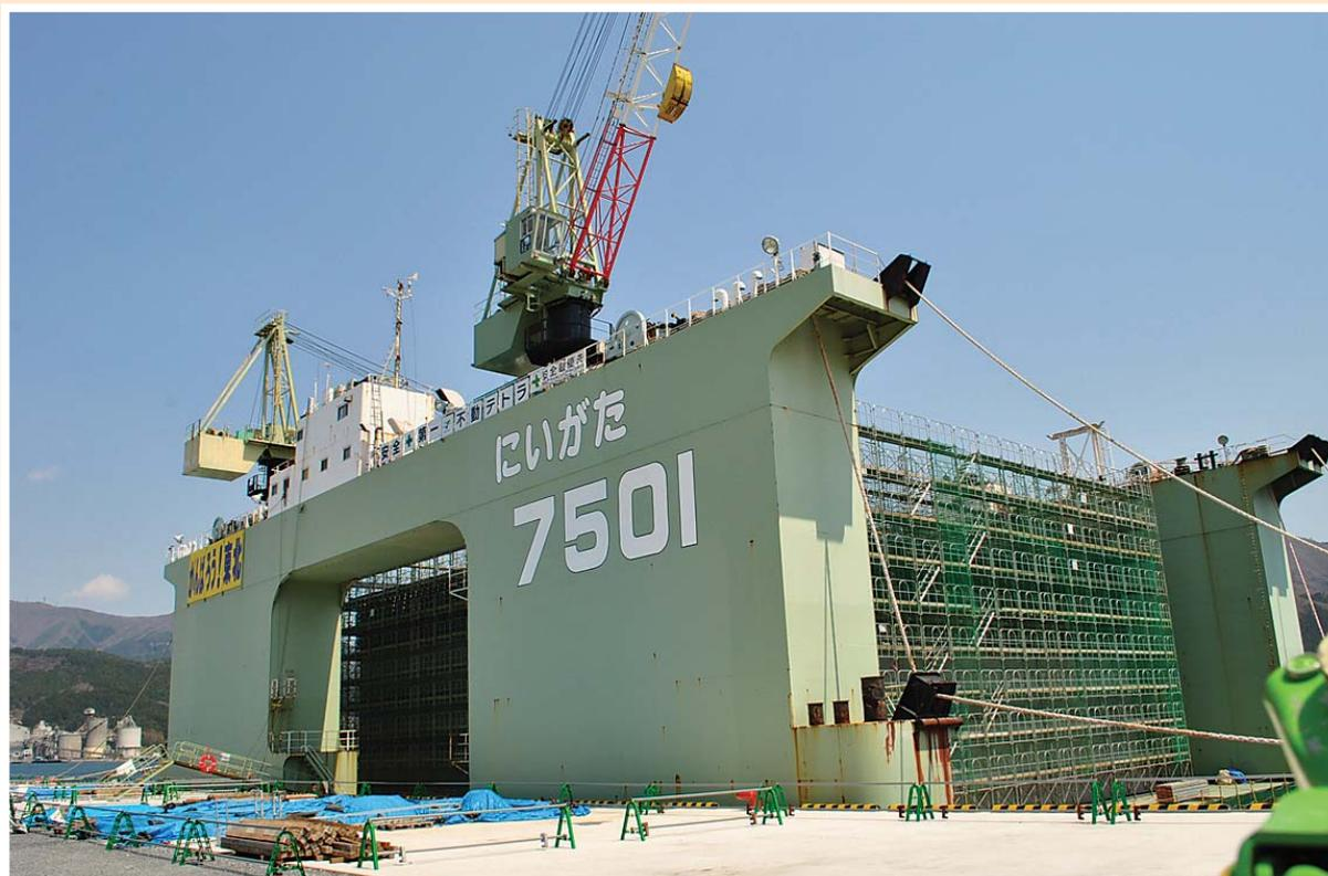
大船渡港湾口防波堤のケーソンを製作するフローティングドック
